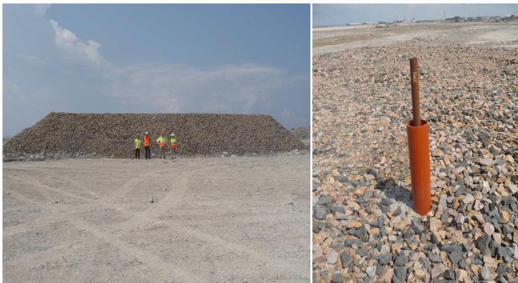
Figur 9. Foto visande en av provbankarna samt den övre delen av en av de markpegel som användes för sättningsuppföljningen.
