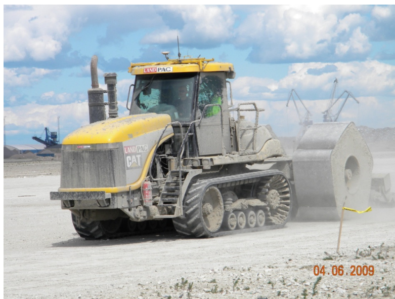
Figur 7. Aktuell Landpac-vält under packningsarbetet i Norra Hamnen.
